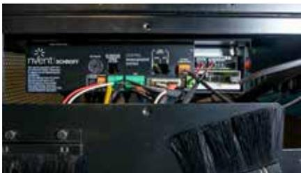
**La connexion entre le contrôleur CMS et l'outil de mise en service se fait via un connecteur RJ11 qui se branche à l'arrière de l'outil de mise en service et du contrôleur CMS.**
